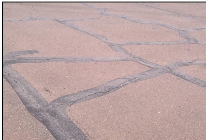
Figure1. Dégradation de la piste suite au matelassage du sol
