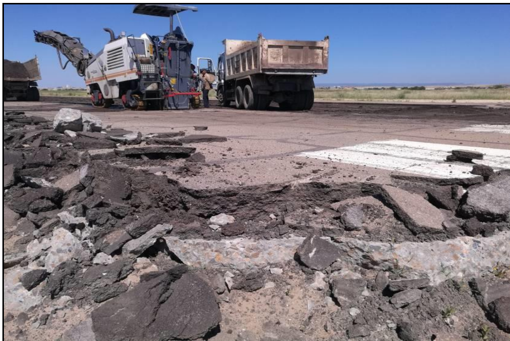
Figure 6. Début de la démolition de la piste principale
