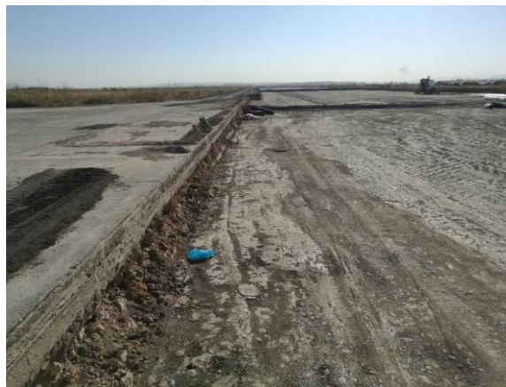
Figure 2. Décaissement de 1 mètre pour substitution du sol et traitement par géosynthétiques
